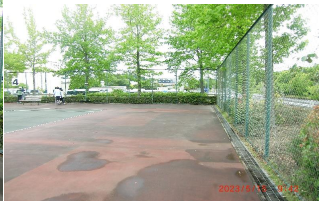
4番コート南側作業終了後
