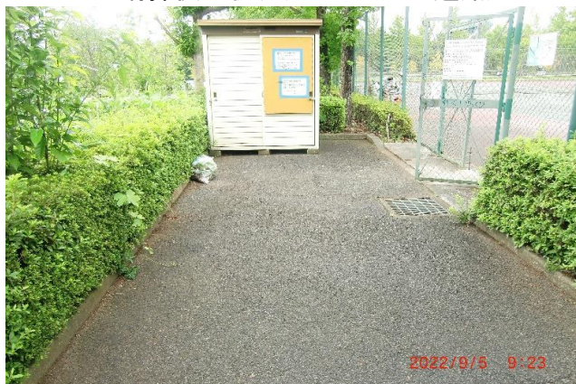
清掃後の状況(コート出入口通路)
