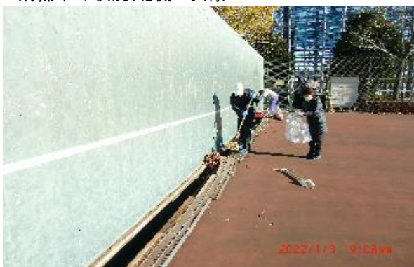
清掃中の状況(北側U字溝)
