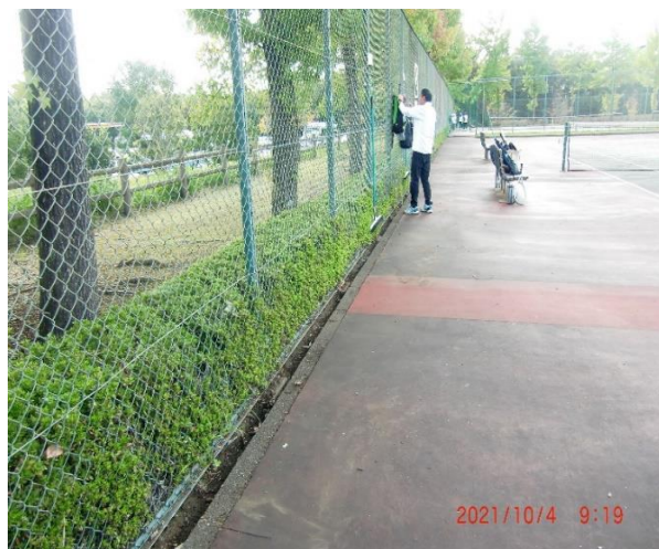
作業後の状況
