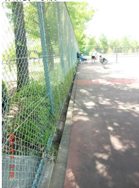
作業後の状況
