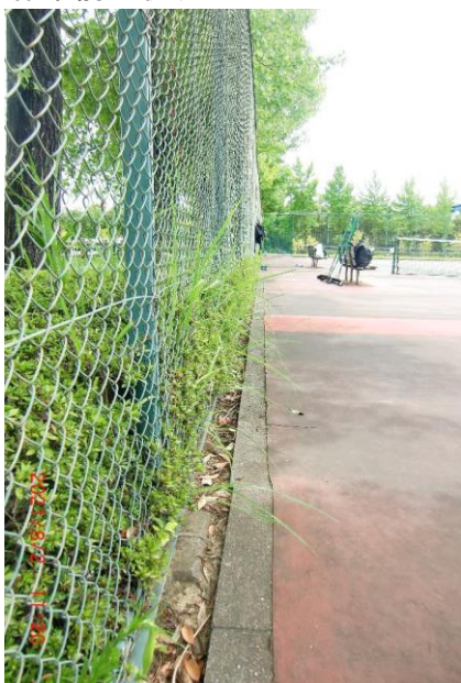
作業前の状況
