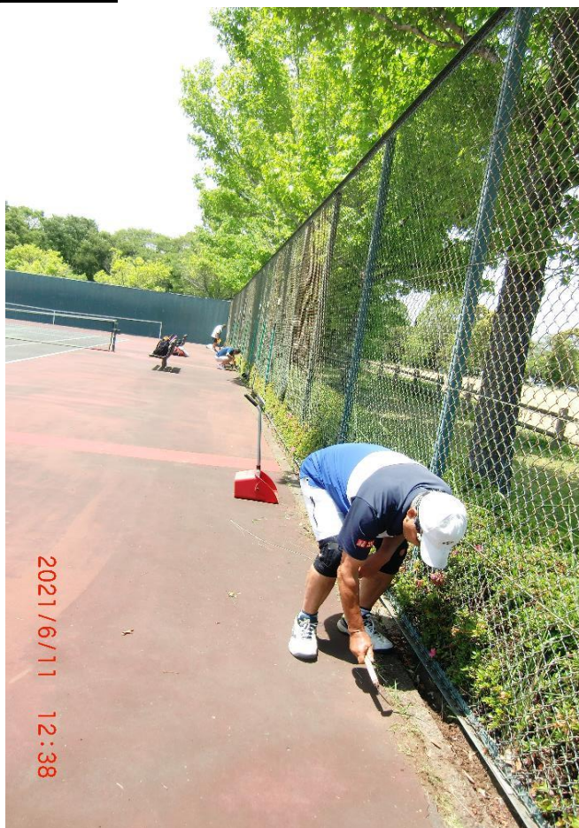
東側フェンス沿い素掘り側溝の清掃中
