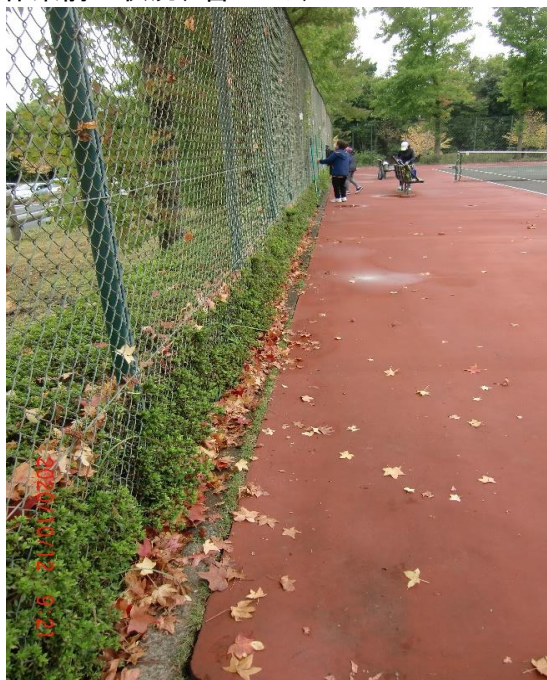
作業前の状況(4番コート)
