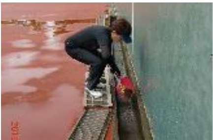
2 番コート北、東側溝の清掃を実施
