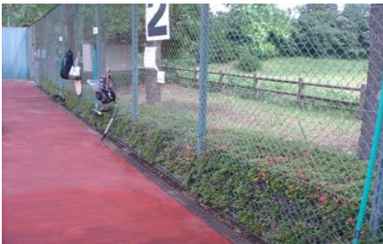
2番コート北、東側溝の清掃を実施
