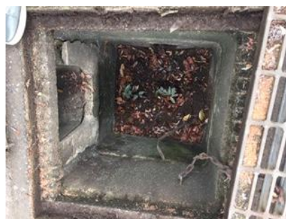
落ち葉を取り除いた側溝
