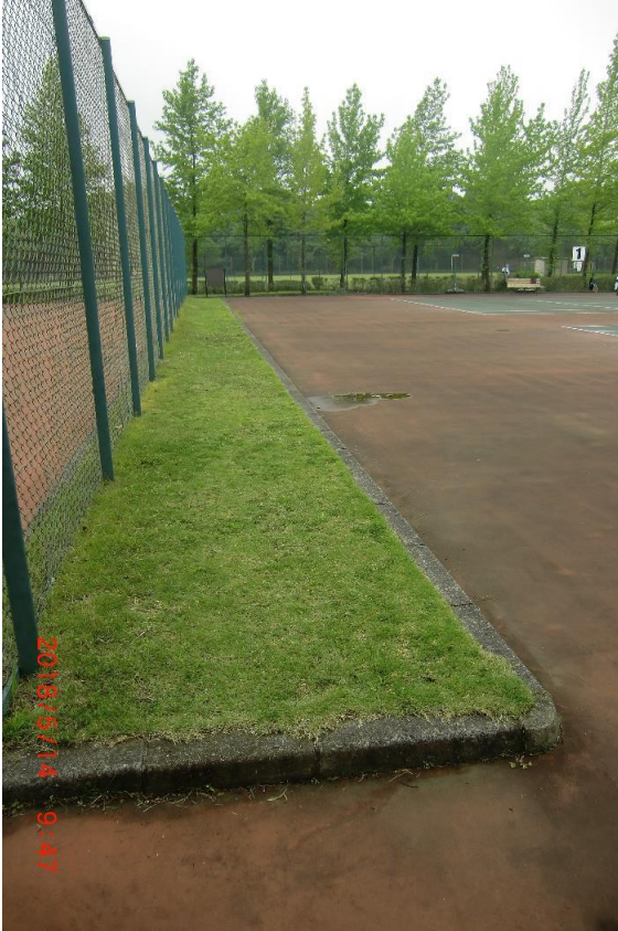
③ 2番コートフェンス沿い素掘り側溝整形後状況
