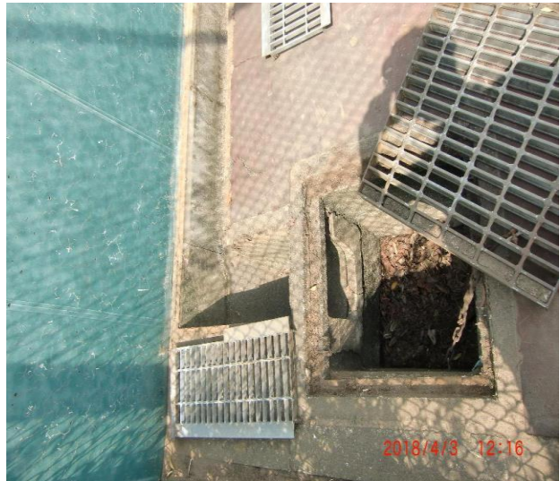
清掃後の集水桝
