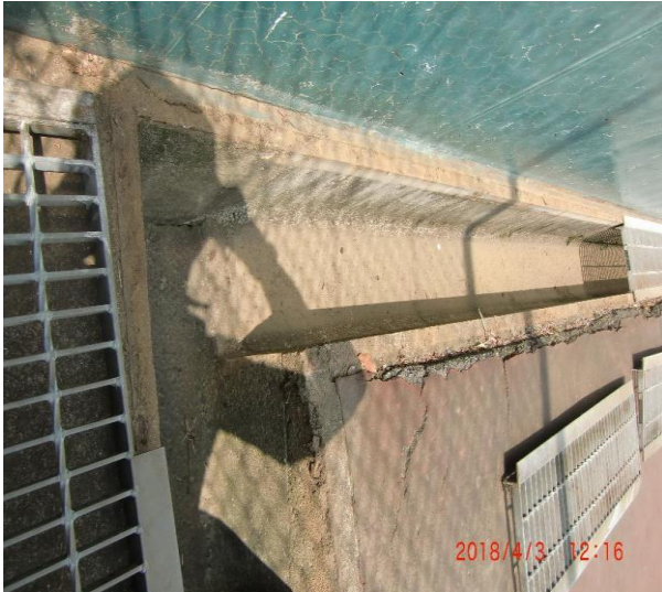
清掃後の側溝
