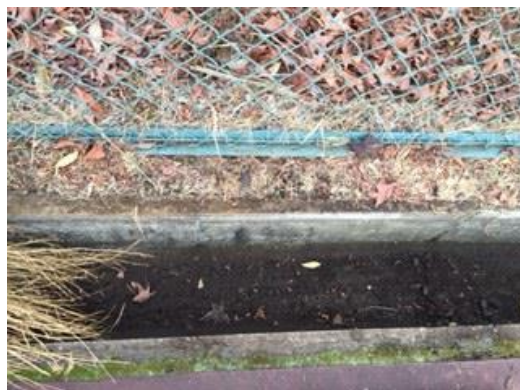
落ち葉を取り除いた側溝
