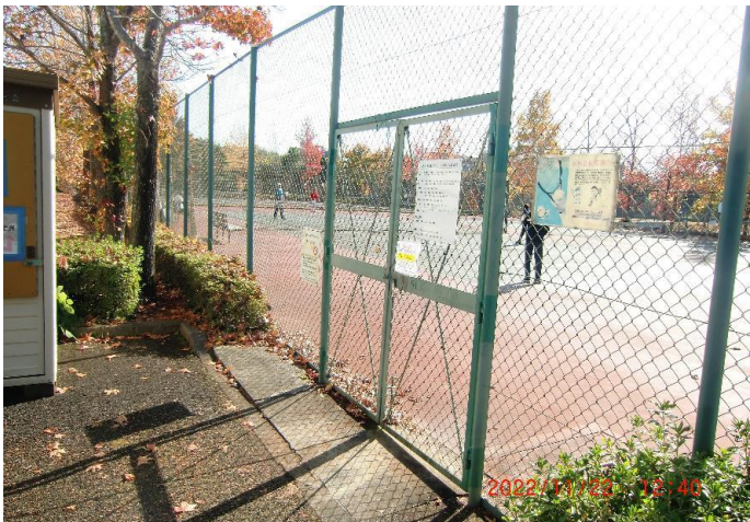
コート出入口の状況
