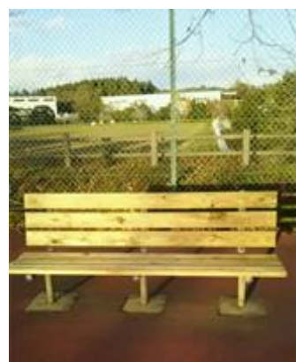
[ベンチ補修後]
