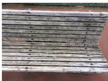
[ベンチ補修前]
